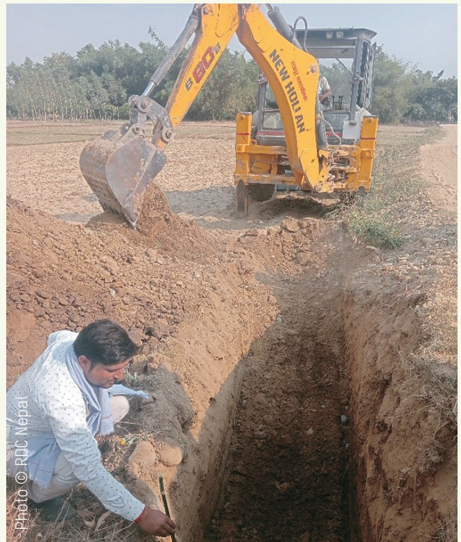
चित्र २ : राजपुर खानेपानी तथा सरसफाई बोर्डका व्यवस्थापक मुख्य पाइपलाइनको गहिराइ नाप्दै ।
