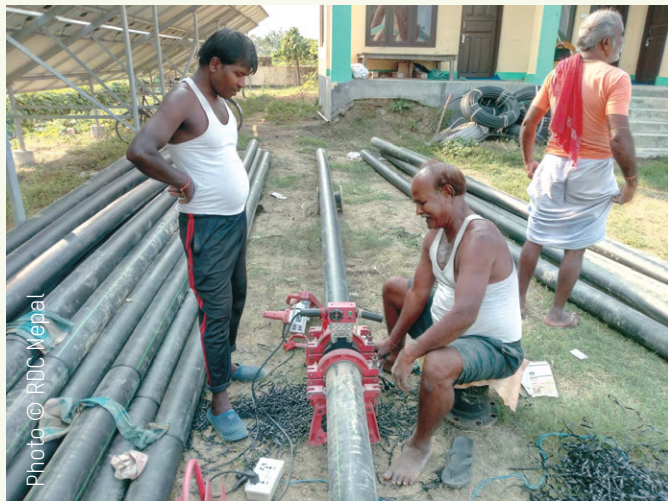
चित्र १ : फतुहा महेशपुर खानेपानी आपूर्ति योजनामा बेल्लिङ मेसिनमार्फत पाइप जडान गरिँदै ।
