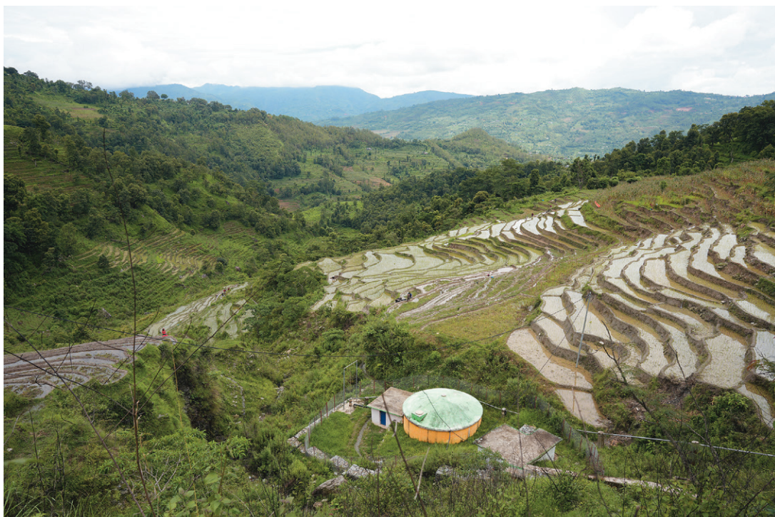
बागमती प्रदेशको धादिङ जिल्लामा रहेको लिफ्ट प्रणालीयुक्त रिजर्भ ट्याङ्की । तस्वीर: सुस्मा पन्त/अक्सफाम
