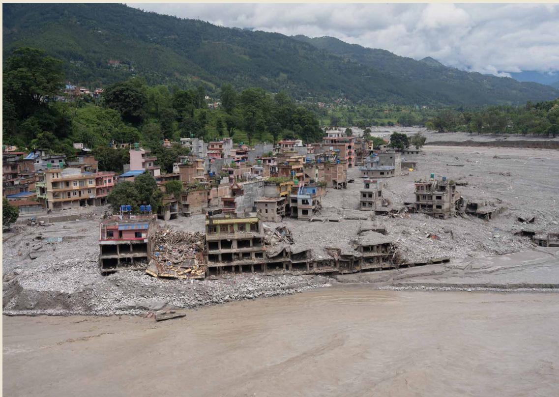
Des logements endommagés par les inondations, à Trishuli Bazar, dans le district de Nuwakot. Photo : Sharada Bashyal/Oxfam
